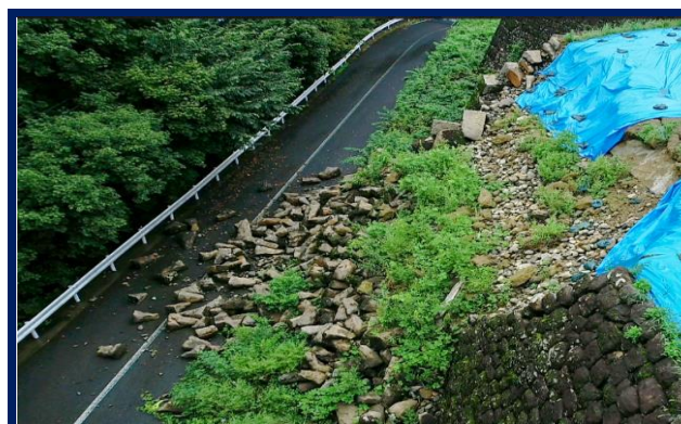
災害現場の測量調査
